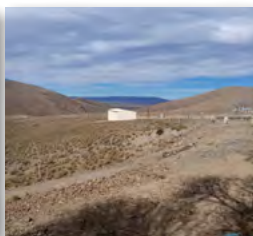
Planta de residuos cloacales
