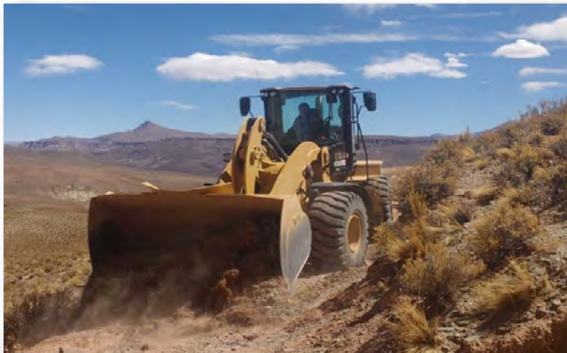
Arreglando el camino hacia Casti
