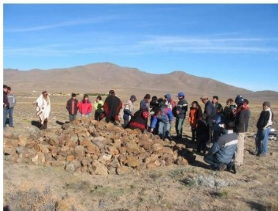
Foto 69. Finalización de la construcción del nuevo chenque.
