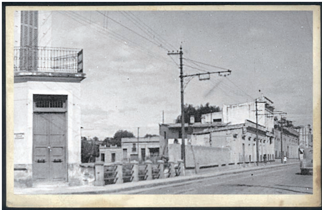
19| Puente de Belgrano y Fructuoso Rivera, a la izquierda se observa la Casa de Pepino. Foto: Tristán Paz Casas, año 1944. Reproducida en C. Boixadós y S. Barbieri, El cauce viejo de La Cañada, Fotografías 1885-1945 , Córdoba, 2005, p. 26.
