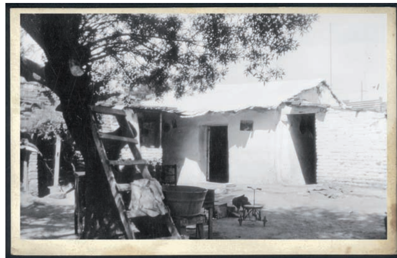
23| Vivienda precaria ubicada en Ayacucho 876 y demolida con motivo de la sistematización de La Cañada. Reproducida en C. Boixadós y S. Barbieri, El cauce viejo de La Cañada, Fotografías 1885-1945 , Córdoba, 2005, p. 82
