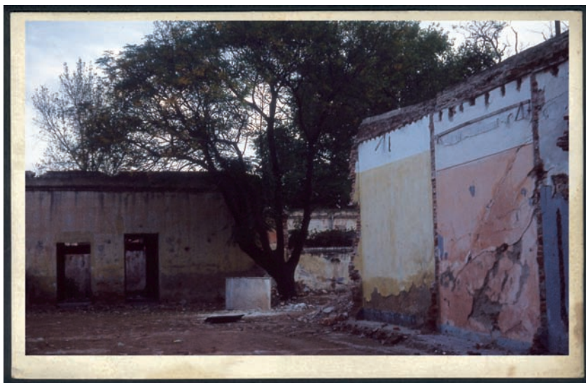
24| Obras previas a la refuncionalización del espacio conocido luego como Paseo de las Artes. Foto: M. Cristina Boixadós, 1979.
