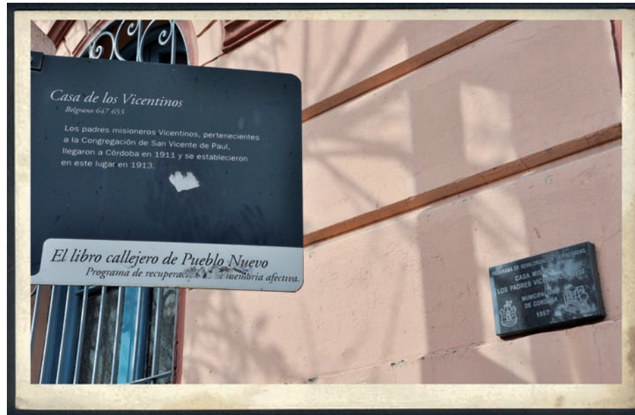
025 b| Algunos de los edificios recuperados por el programa de refuncionalización de fachadas y parte del Libro Callejero de Pueblo Nuevo.
