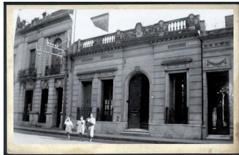
27| Una de las viviendas demolidas por motivo de la sistematización de la Cañada en el año 1944, perteneciente a la familia de M. H. Garzón y ubicada en 27 de Abril 510. Foto: DIPAS. Reproducido en Boixadós, M. Cristina y Barbieri, Sergio. El cauce viejo de La Cañada, fotografías 1885-1945 , p. 84.
